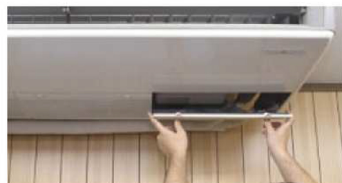
エアコンフィルターの扉を開ける
