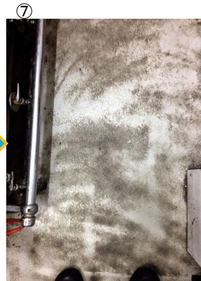
⑦ 油で汚れている床を洗浄します。グリストに残っている溶液を床にまき、ブラシで軽くこすります。
